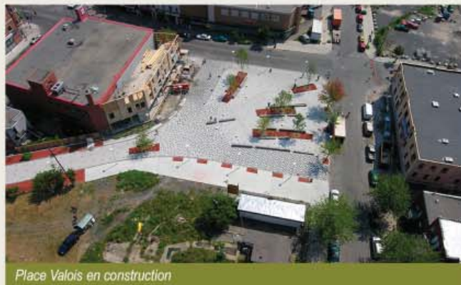
Place Valois en construction
